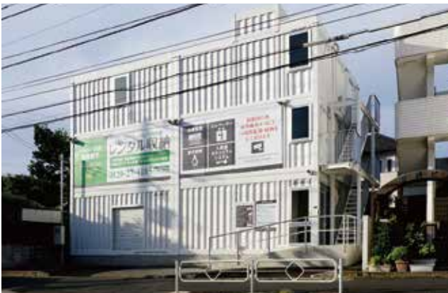
3階建てモデル (港南笹下トランクルーム)
